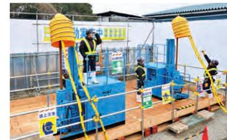
セメント液を高圧で噴射し、円柱状の改良体を造成する工法です。
