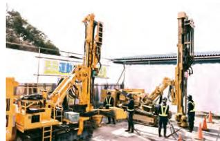
特殊注入管(ダブルパッカ)にて薬液を注入し、地盤を強化する工法です。
